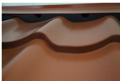
Уплотнители для металлочерепицы применяются для предотвращения проникновения дождя, снега, пыли и насекомых в узлы стыков металлочерепицы и элементов отделки кровли.
