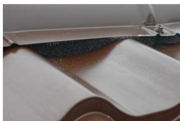
Уплотнитель из пенополиуретана предотвращает проникновение в подкровельное пространство воды, снега, опавшей листвы и пыли.
